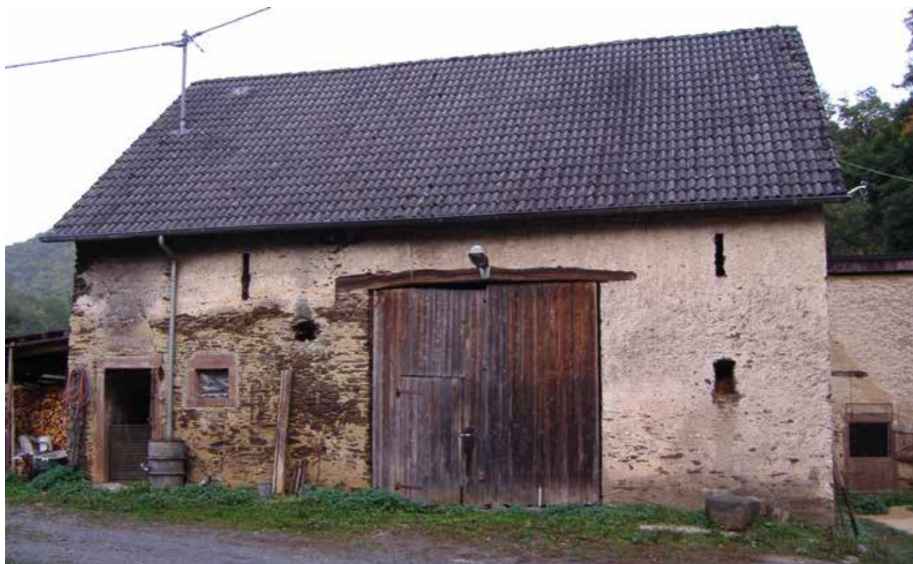
LINKSSEITIGES WIRTSCHAFTSGEBÄUDE (2006) 1811 NOCH STROHGEDECKT
